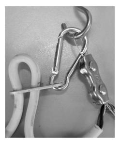
**6.** Connectez les câbles audio à la ligne provenant de l'amplificateur et faites remonter le capuchon en plastique jusqu'au plafond, recouvrant ainsi les éléments de fixation pour terminer l'installation.
